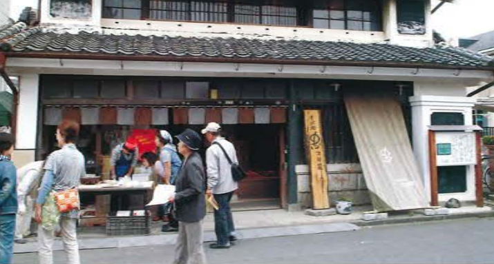
朽木さんが改修設計を手掛けた忠次郎蔵。正面は昔の店舗部分
